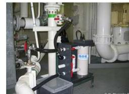
Figure 2. Thermosalinographe en salle des machines.
