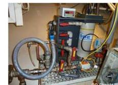
Figure 2. Thermosalinographe en salle des machines.
